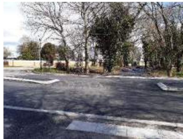
Travaux en cours – traversées en 2 temps avec îlot central
