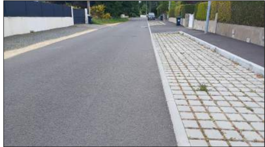
Stationnement perméable à joints gazon (route de Kerloes)
