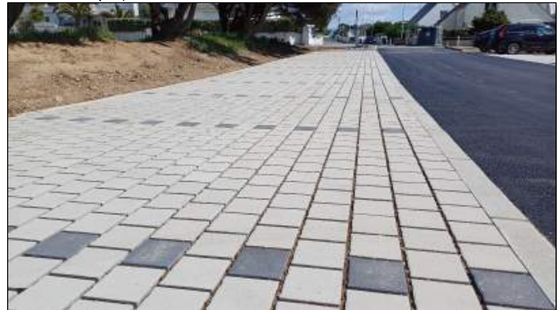
Stationnement perméable à joints gazon (Place des Goémoniers, à Fort Bloqué)
